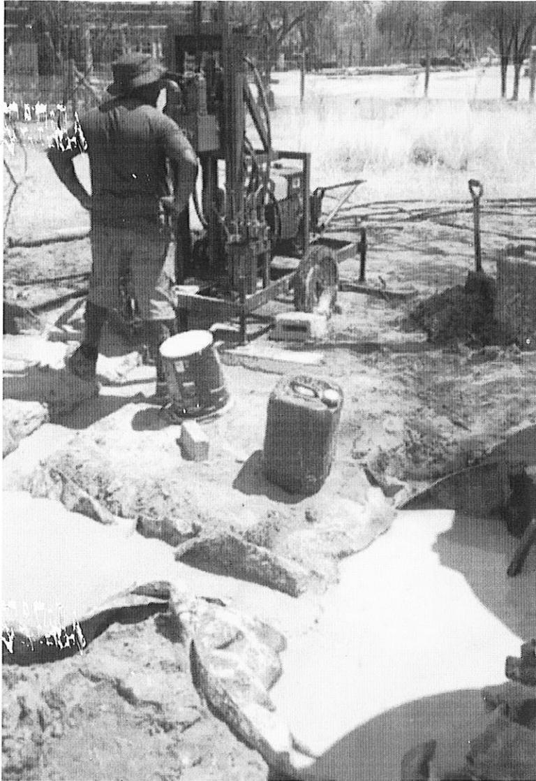
7. El motor diesel es de arranque eléctrico. Abra la palanca de control de velocidad; abra la palanca de descompresión; presione el interruptor para arrancar el motor diesel.
