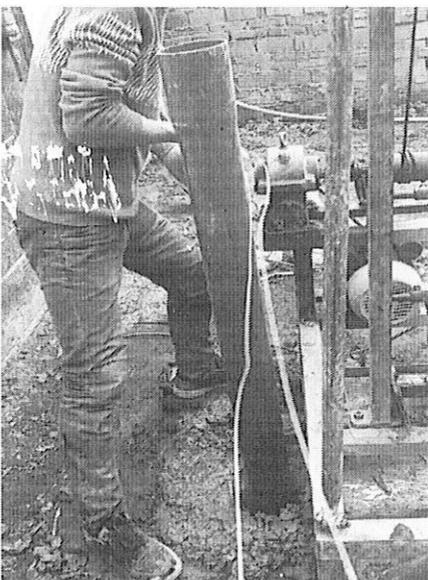
14. la tubería inferior de PVC debe perforarse en muchos agujeros pequeños y enroscar la tubería de PVC con una gasa.
